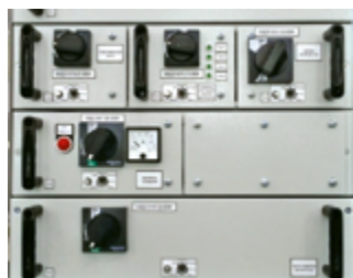
Отсек функциональных блоков
