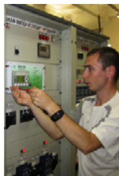
Дооснащение работающего ЩПТ оборудованием ЭКРА-СКИ
