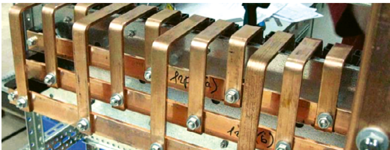
Крепление сборок медных шин при помощи тарельчатых шайб
