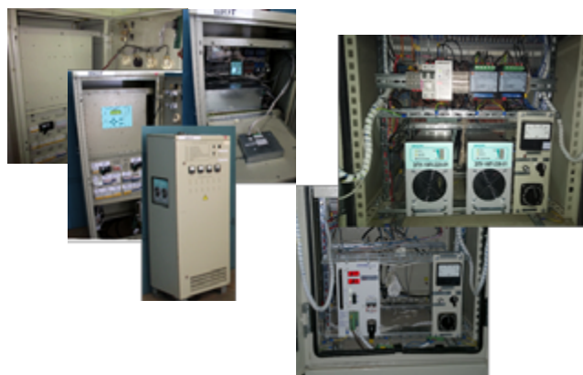
Замена старых блоков питания в СОПТ на ЗПУ-10
